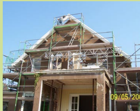
Das Dach wurde komplett gedämmt und neu eingedeckt; alle Fenster tauschte man aus
